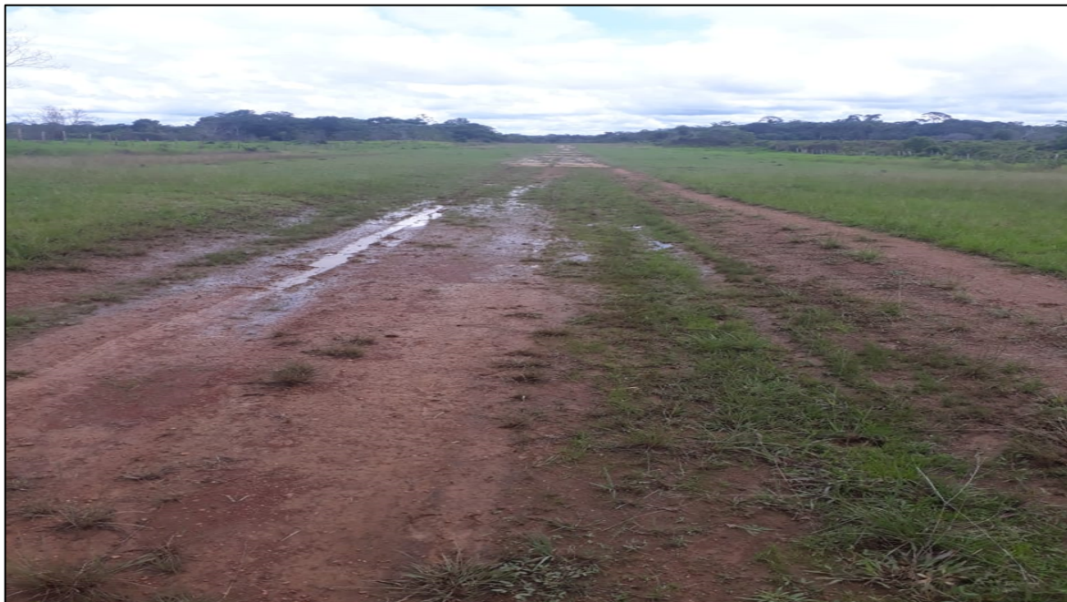
Fotografía No. 3 - Vista de la pista desde el umbral de la cabecera 12
