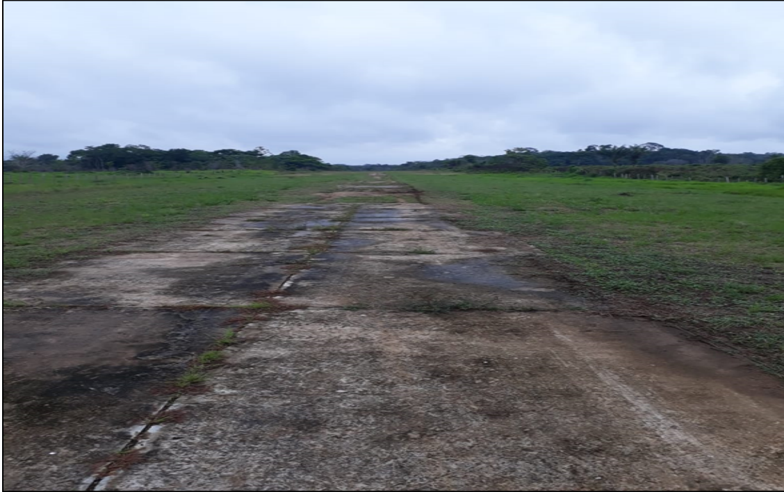
Fotografía No. 4 - Vista de la pista desde el umbral de la cabecera 30
